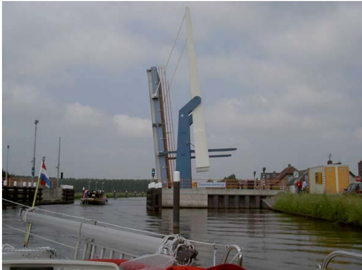
En av många öppningsbara broar
